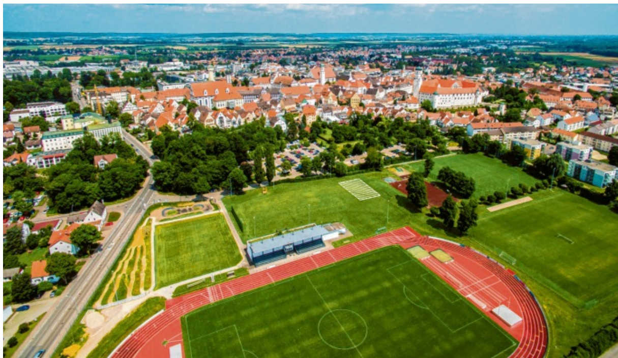
Die neue Dillinger Skate-Anlage war ursprünglich beim Jugendcafé vorgesehen. Jetzt wird sie weiter nördlich in Richtung der Colleg-Parkplätze errichtet (schraffierte Fläche). Links sind der neue Dirt-Park und der Pumptrack zu sehen. Foto: Jan Koenen, Stadt
