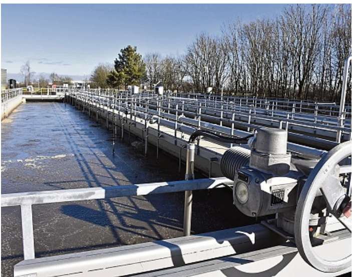
Künftig soll das gesamte Abwasser des Gewerbegebiets über die neue Pumpanlage gefördert werden. Das bestehende Pumpwerk bleibt jedoch erhalten und wird bei Wartungen genutzt.
